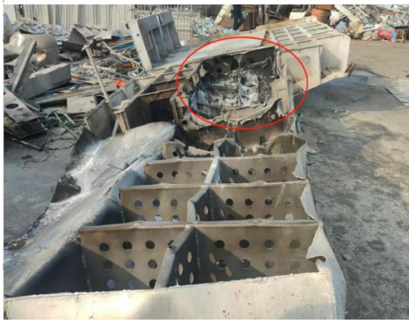
图 1：拆除现场爆炸处
