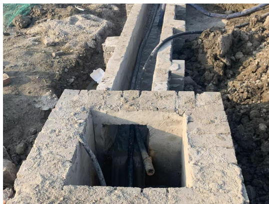
图 3.3-2 排水沟及沉沙池 (2024.12)
