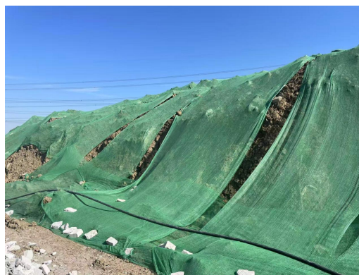
图 3.3-4 堆土区临时苫盖 (2025.10)
