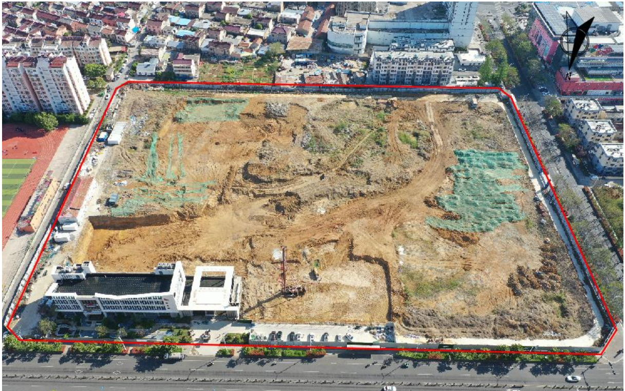
图 2-9 项目工程现状图（2025 年 4 月）
