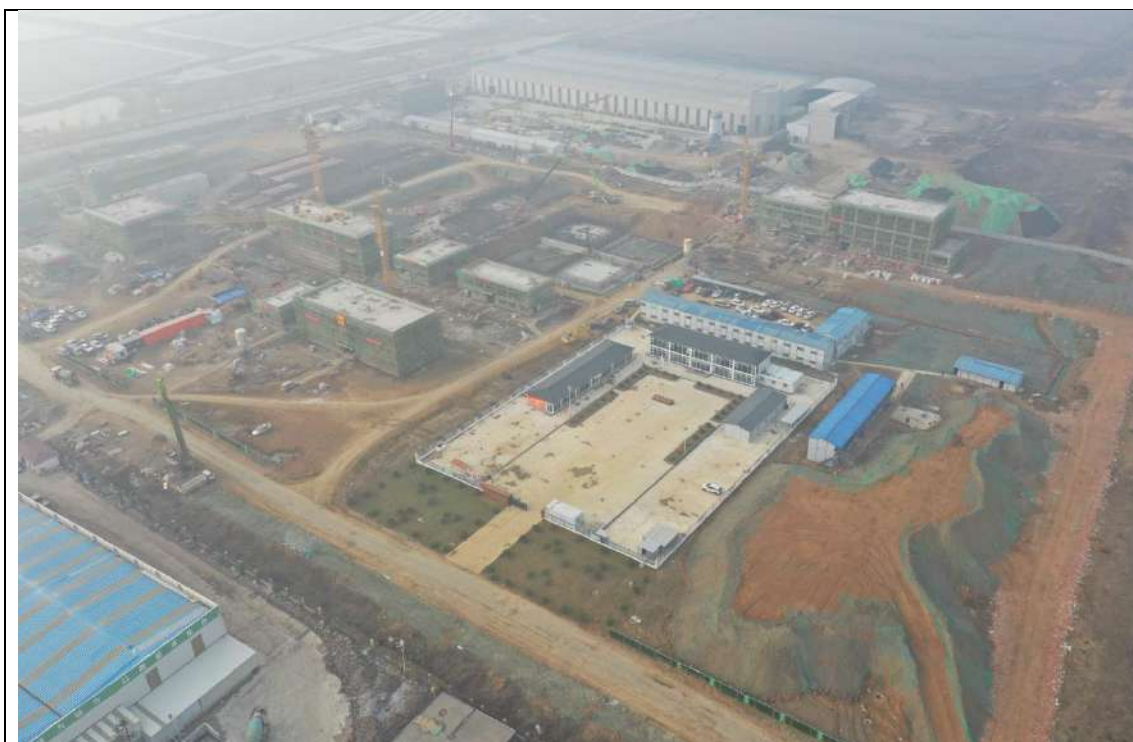
水厂施工现状
